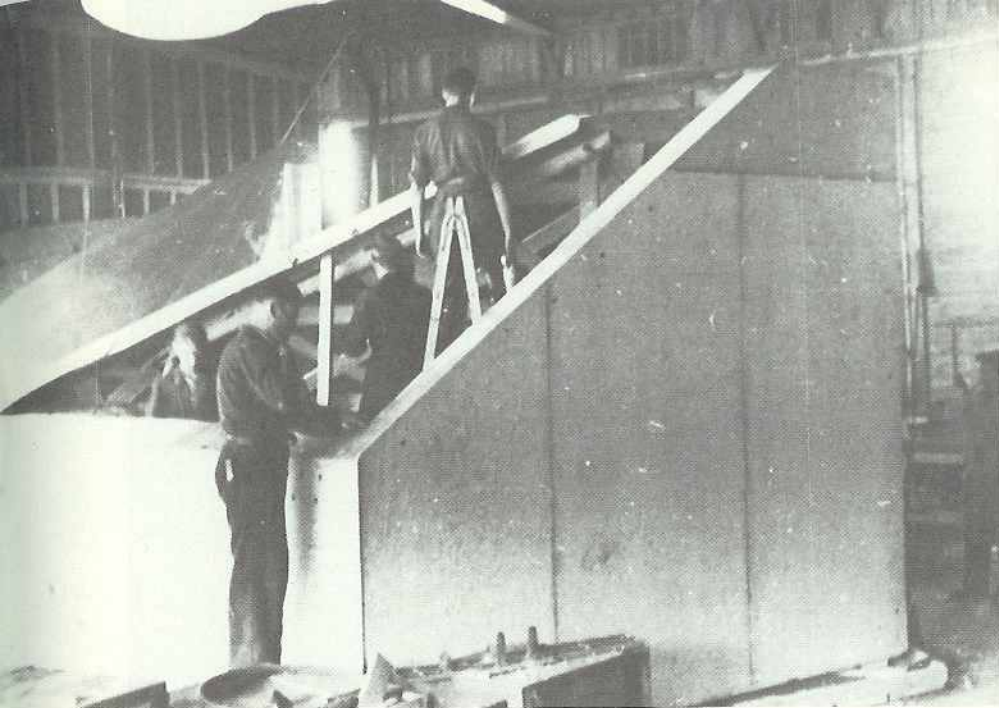
Bau der "maßgeschneiderten" Transportkiste. Die DM-1 wird eingepaßt (das Seitenflossen-Endstück ist abgenommen) und anschließend mit wetterfester Folie überzogen und die Luft mit Hilfe eines Staubsaugers (unten rechts) abgesaugt.
