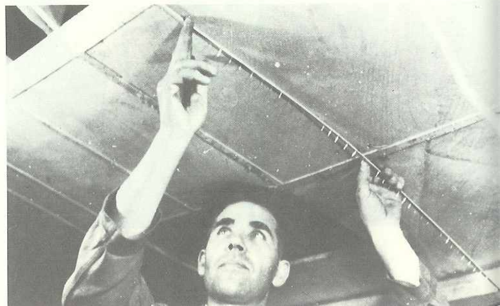
Beplankung der Unterseite. Bei der Arbeit: Schneiders von der FFG Aachen.
